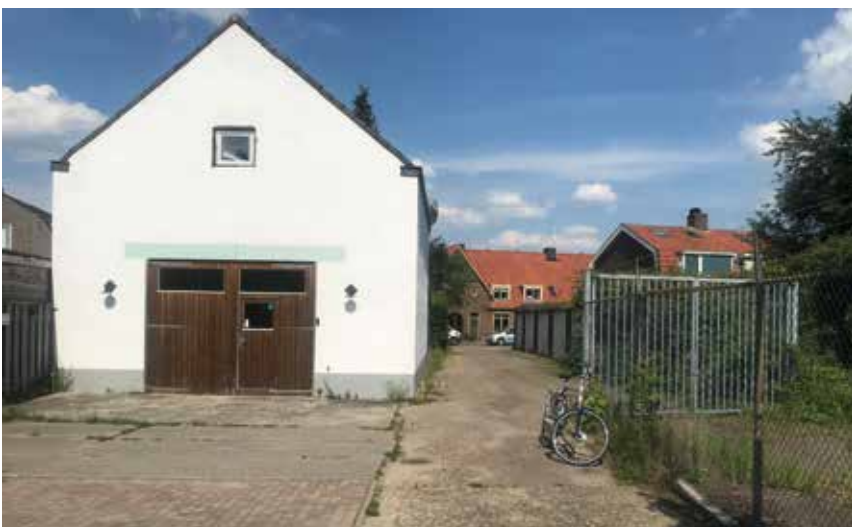
🕒 De Hogedwardsstraat in 2022. De meeste woningen zijn gesloopt (Foto auteur)
