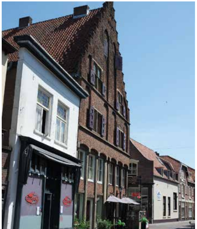
Gevel gotische huis in de Weerstraat hoek Kleibergsestraat (Foto auteur)
