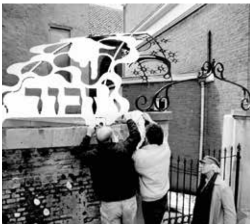
▲ Het plaatsen van het monument april 1996 (Collectie RAR/Jan Bouwhuis)
