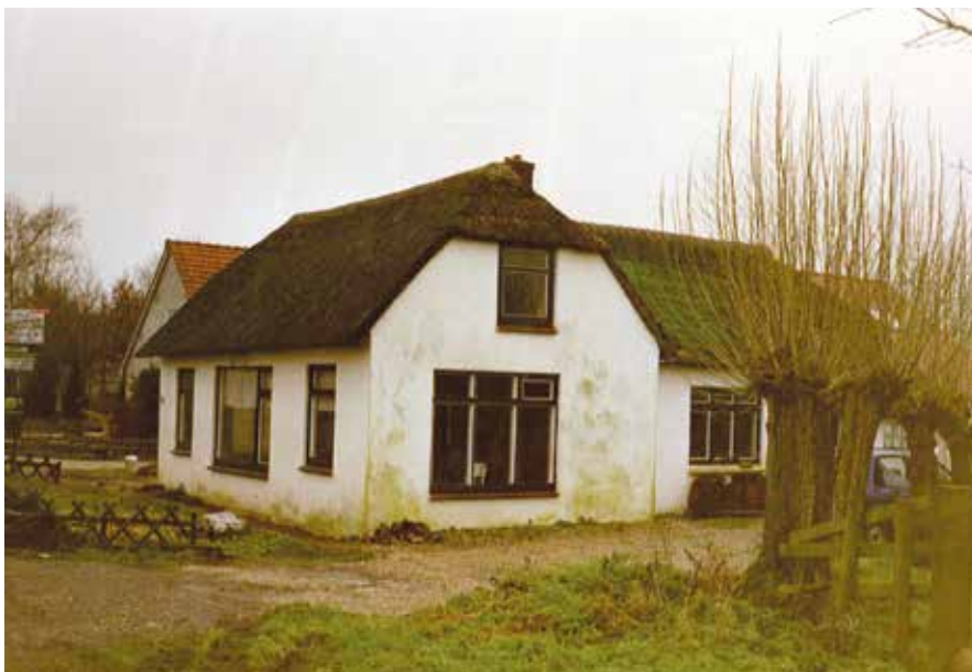
Evacuatiehuis in Everdingen, inmiddels afgebroken (Privé bezit)
