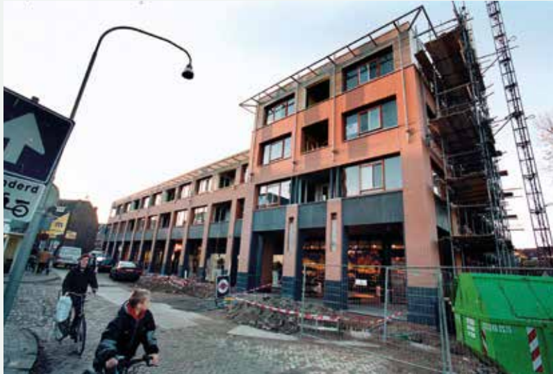
De bouw van het Ravelijn in 1999
